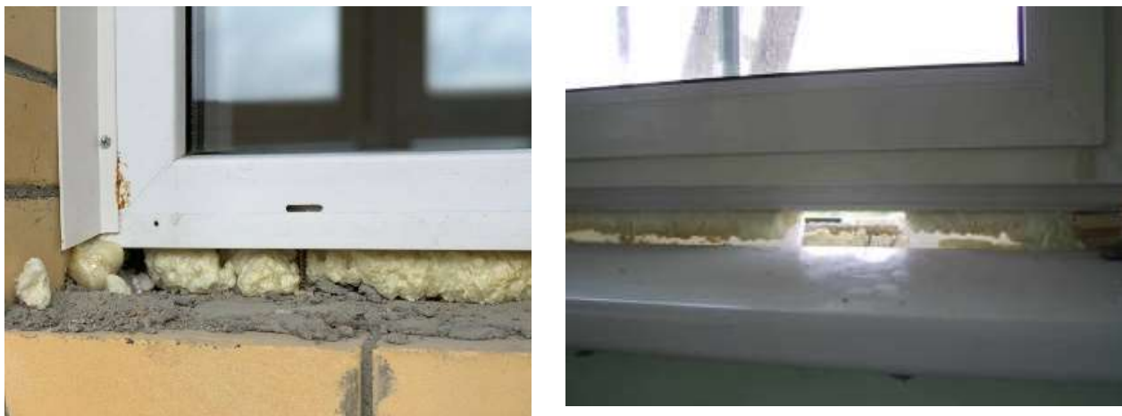
3-расм. Ташқи девор билан дераза туташувини герметизациялаш.
