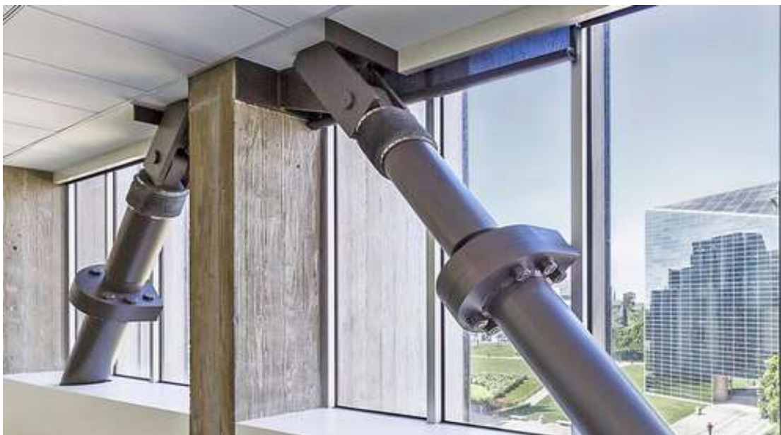
1в-расм. Кўп қаватли бинонинг устунларига демпфер қурилмасининг ўрнатилиши.
