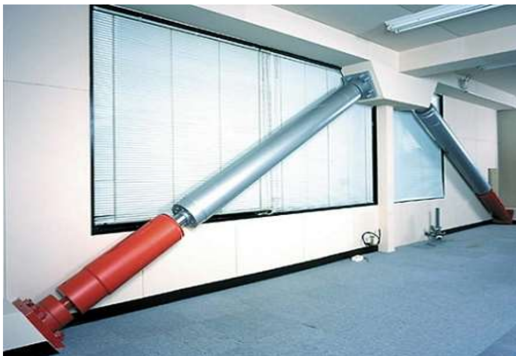
1г-расм. Қовушқоқ демпфер қурилмасининг бинонинг ясси рамасига ўрнатилиши.
