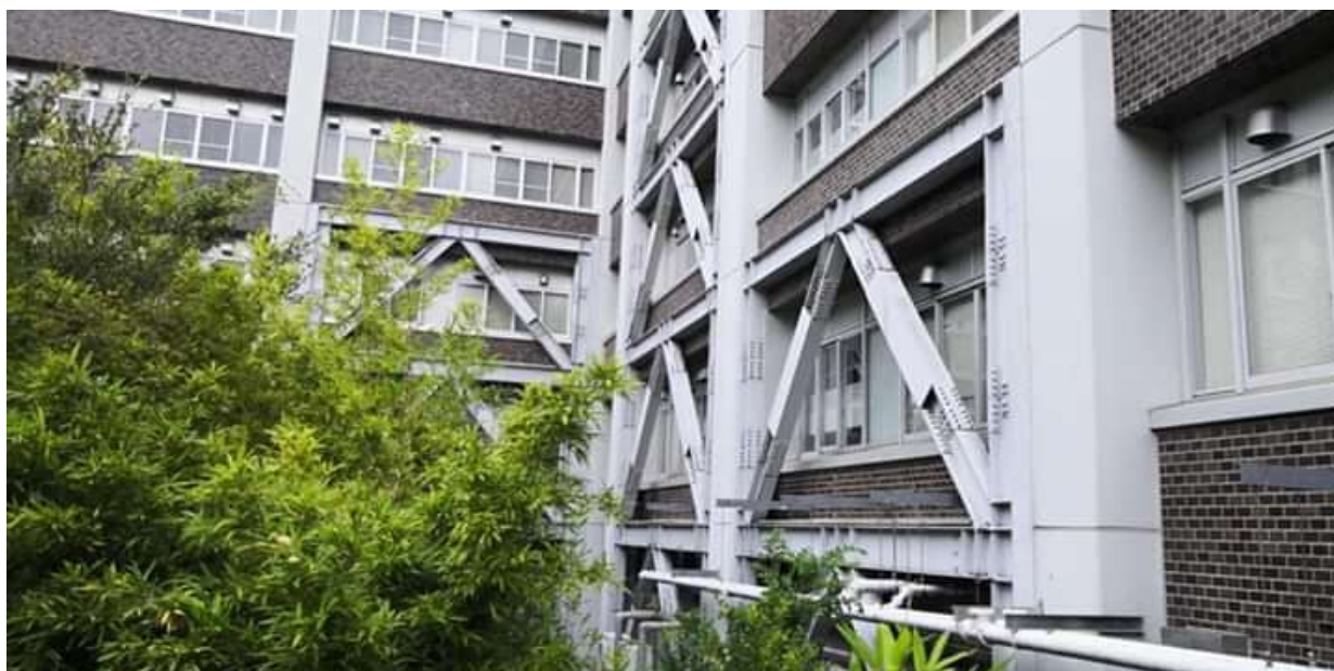
2г-расм. Бинонинг каркасига ўрнатилган фрикцион демпферларнинг ўрнатилиши.
