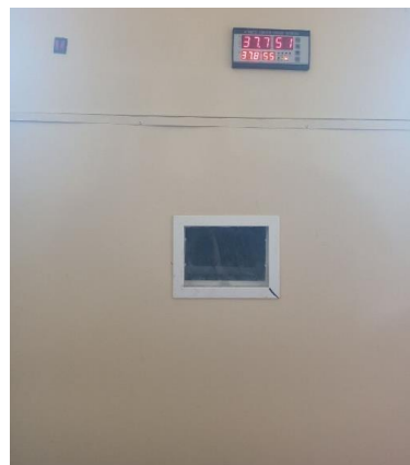
4-rasm. Kameradagi harorat va namlik datchigi.
