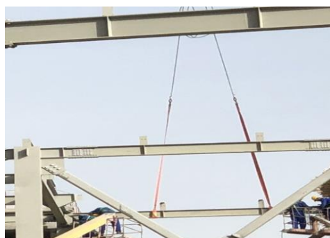
Рис.2. Монтаж конструкций с помощью синтетических строп.
