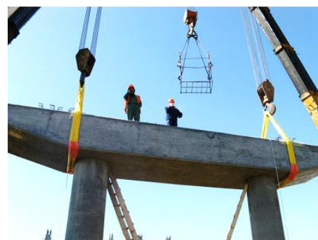
Рис.2. Монтаж конструкций с помощью синтетических строп.
