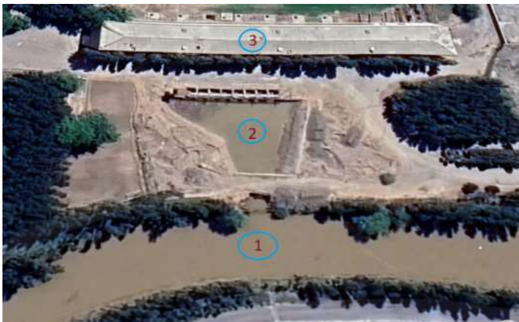
1-расм. КФК-Сўх насос станцияси умумий кўриниш.
