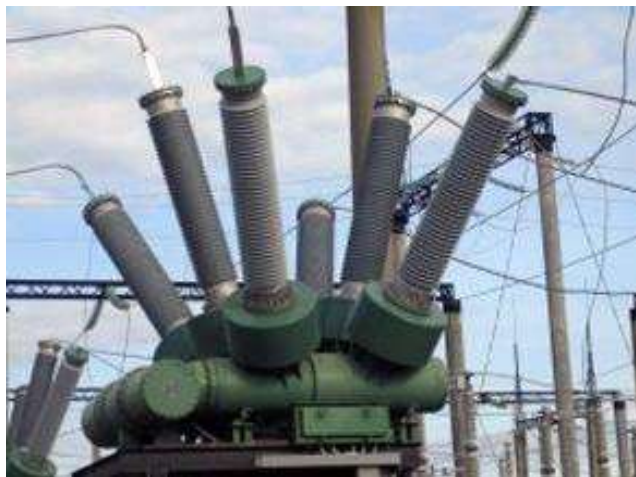
2-расм. ВЭБ-110 Элегазли бакли ўчиргичнинг умумий кўриниши.
