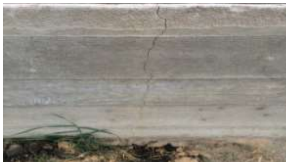
1-2-rasmlar. Poydevorda hosil bo'lgan yoriqlar
