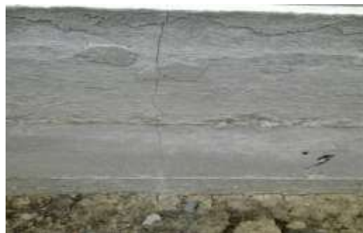
1-2-rasmlar. Poydevorda hosil bo'lgan yoriqlar
