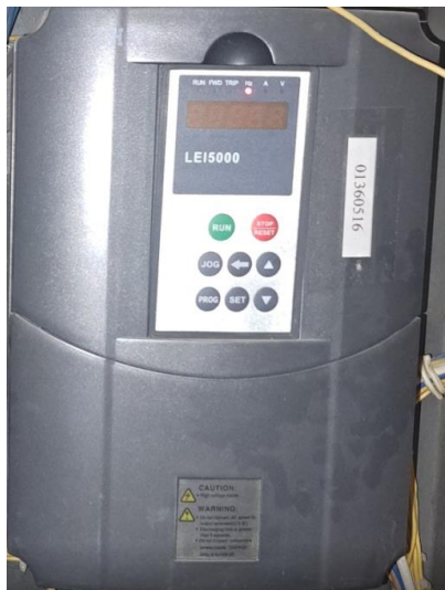
Рис. 3. Частотный преобразователь 5,5 кВт с LEI5000-5R5-PB-3.
