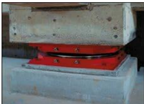
Рис.4. Скользящие опоры в виде маятниковой опоры трения и рельсового линейного скольжения зданий
