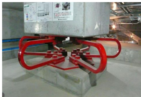
Рис.5. Дугообразная пружинная упругая опора.
