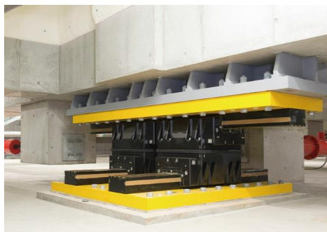
Рис.4. Скользящие опоры в виде маятниковой опоры трения и рельсового линейного скольжения зданий
