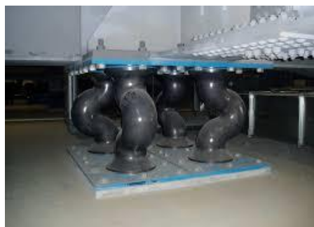
Рис.5 а). Многослойная резинометаллическая опора с фрикционным демпфером и дугообразный свинцовый демпфер
