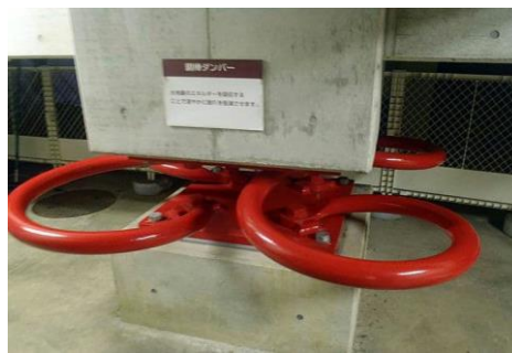
Рис.5. Дугообразная пружинная упругая опора.
