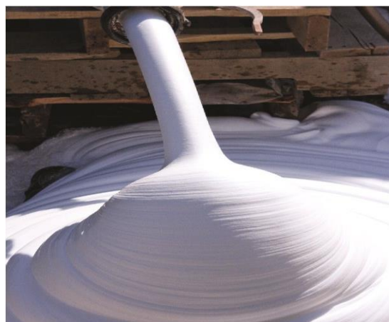
2-rasm. Qurilish maydonida suyuq ko'pikplastik quyish.
