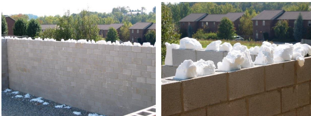
1-rasm. Qurulish jarayonida uylarni penoizol bilan issiqdan himoyalash.
