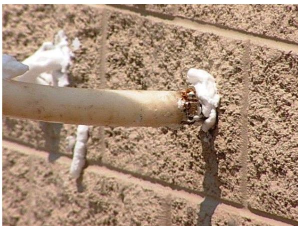
2-rasm. Qurilish maydonida suyuq ko'pikplastik quyish.
