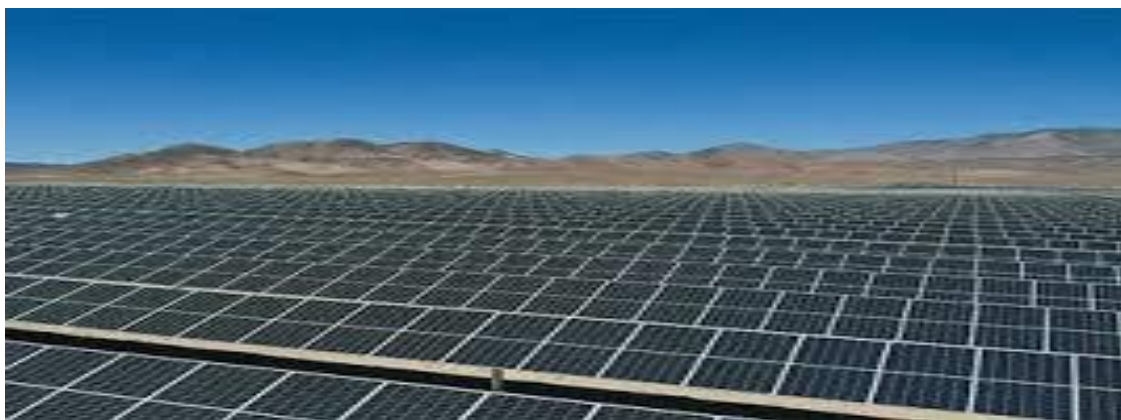
Рис. 1. Установки панелей солнечных электростанций.
