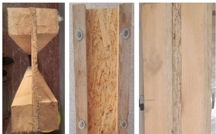
1-rasm. Qo'shtavr kesimli yog'och to'sin modeli.
