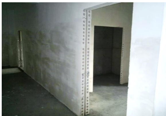
в) ички деворлар учун кўпикфосфогипс блок панелларини монтаж қилиш 666×500×7 мм.
