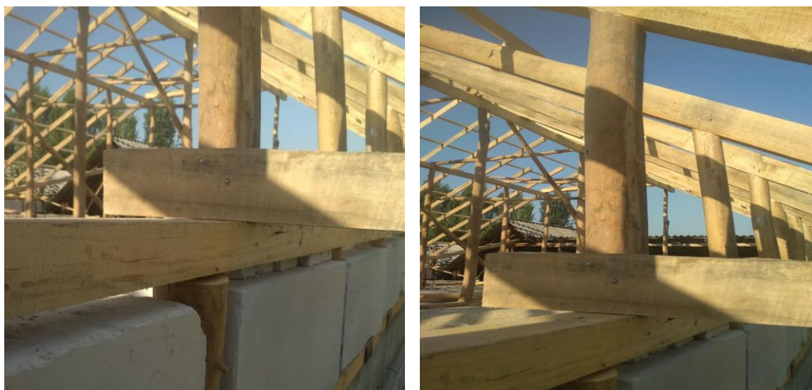
1-rasm Yog'och tom yopma elementlarni birikish namunalari.
